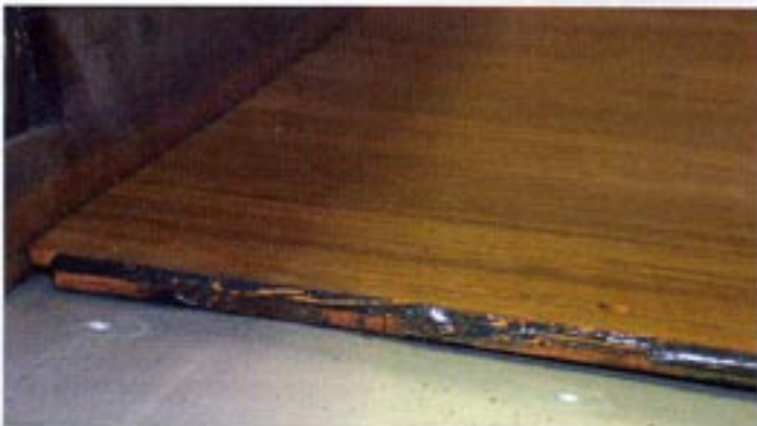
Hier sieht man die untere, längsverlaufende Schicht, die von der Mittel- lage abgesperrt wird. Darüber werden die Teakdeckleisten konventionell verlegt, sodass eine Drei-Schicht-Sperrholzplatte komplett aus Teak entsteht.
