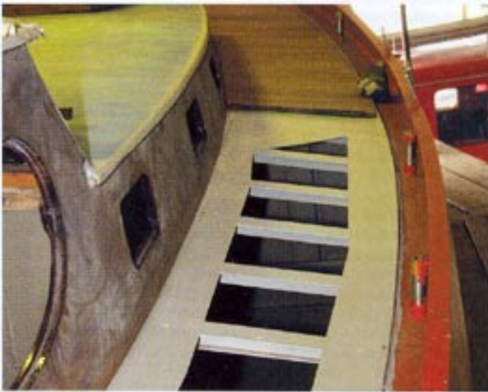
Die ersten beiden Schichten des Decks werden zweischichtig im Vakuum hergestellt und segmentweise dauerelastisch auf die Stahlverbände geklebt.
